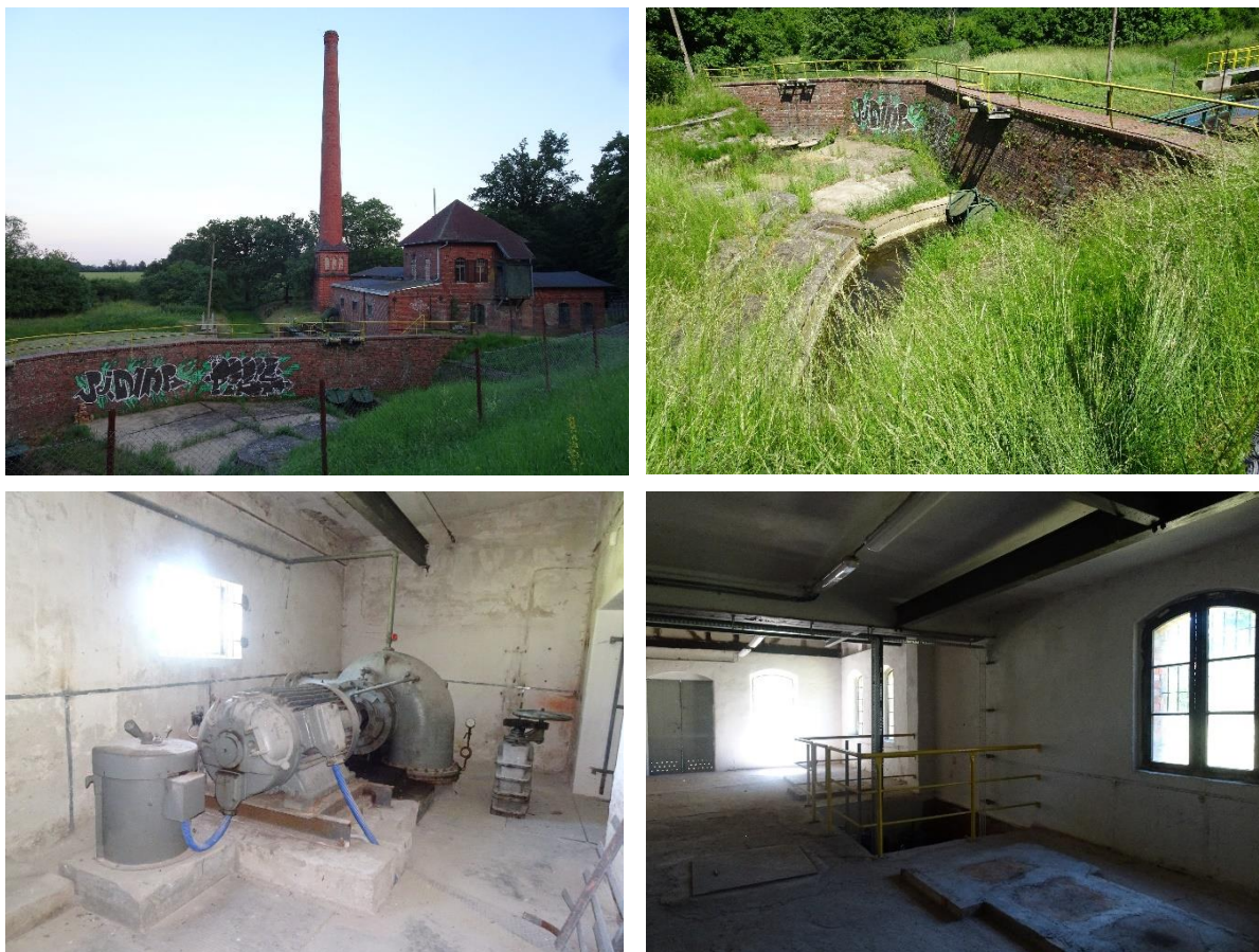
Fot. 10. Przepompownia „Rędzin” (fot. J. Furmankiewicz)
