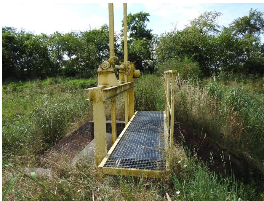
FotPor 1. Zastawka na osadniku, tzw. „stawidło” – ceglano-metalowa konstrukcja hydrotechniczna na osadniku IV (por. numerację na Rysunku 2) (fot. M. Kossowska)
