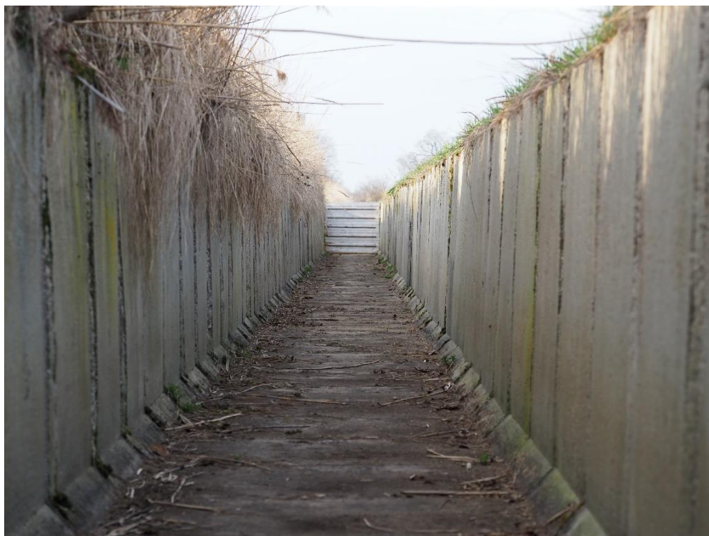
FotHerp 32. Doprowadzalnik z widoczną pochylnią (fot. K. Kolenda)
