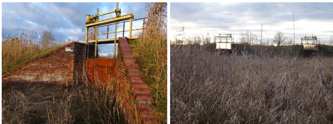
Fot. 9. Infrastruktura techniczna pól irygacyjnych – zastawki w osadnikach (fot. J. Furmankiewicz)
