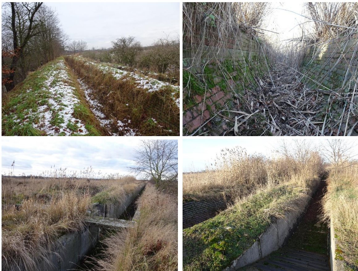
Fot. 8. Infrastruktura techniczna pól irygacyjnych – doprowadzalniki (fot. J. Furmankiewicz)
